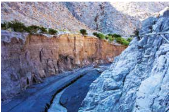
Tramo del camino del Inca que resultó completamente erosionado por el paso del agua
